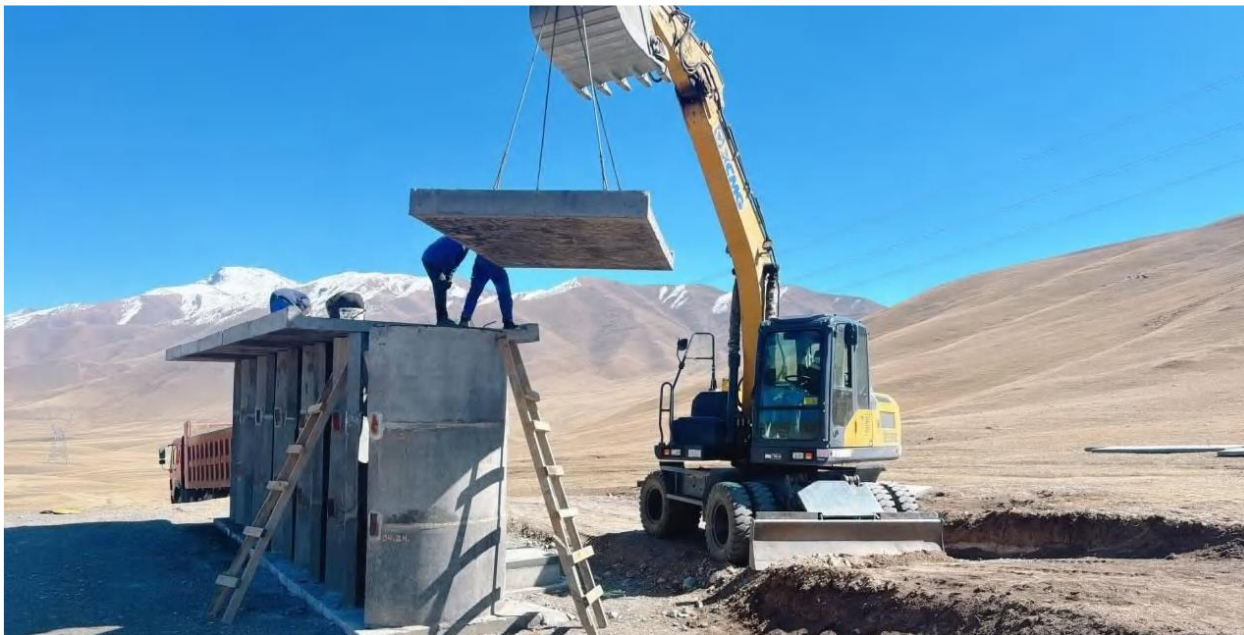
Рисунок 8: Строительство общественных санузлов, км 111+320, ПС
