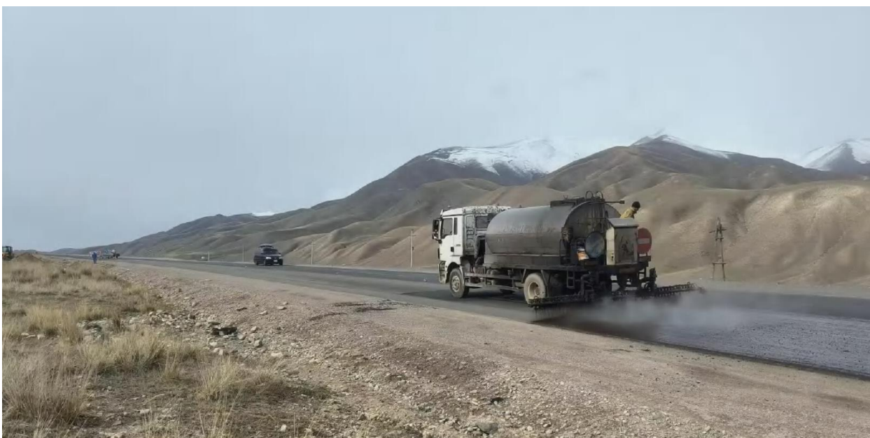
Рисунок 11: Грунтовочный битумный слой, км 102+180 – км 101+120 ЛС
