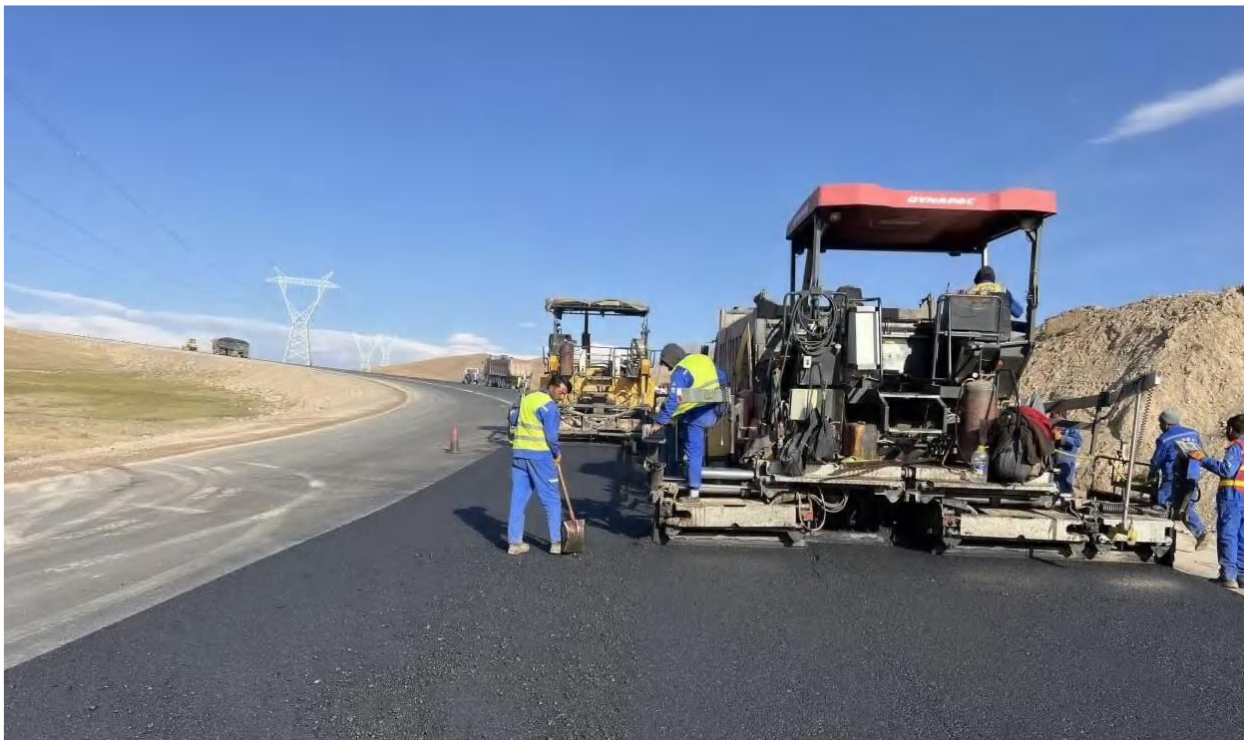
Рисунок 6: Верхний слой асфальтового покрытия, км 113+720 - км 113+160 ЛС
