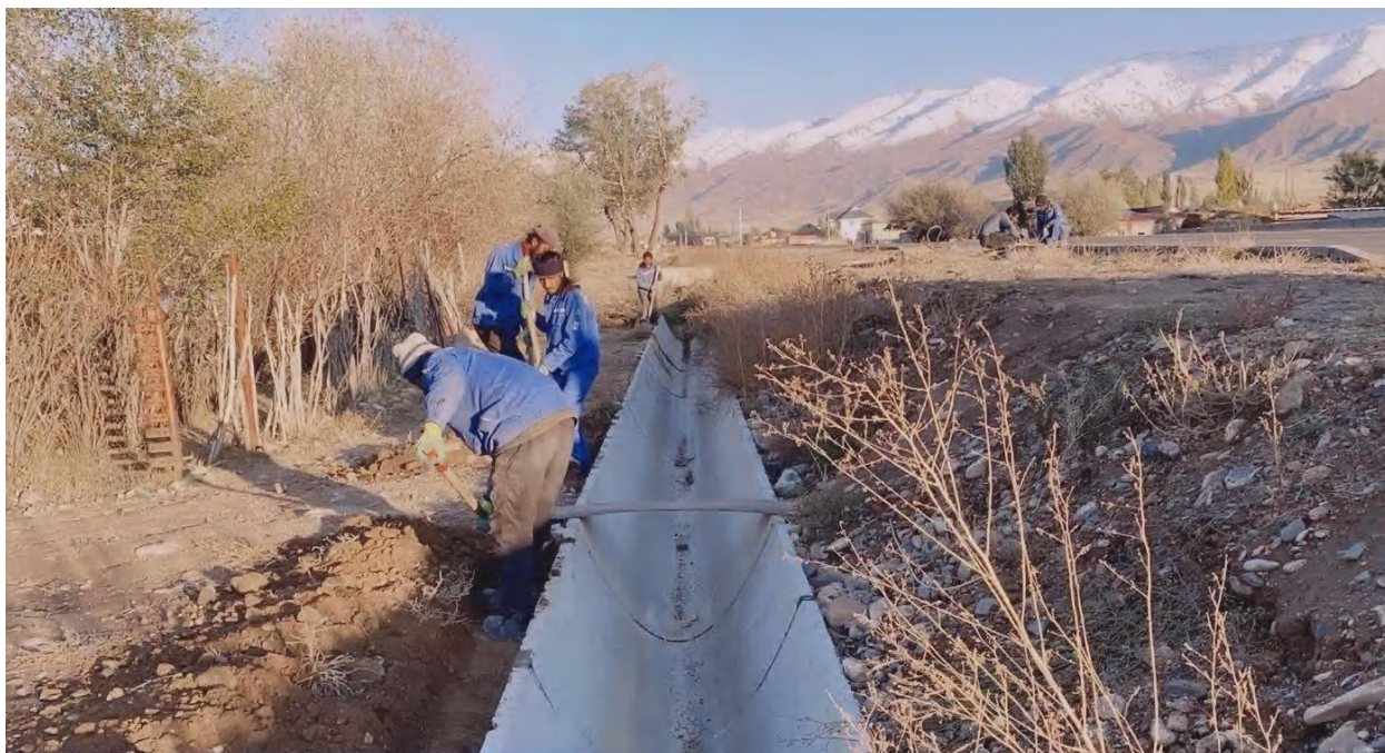
Рисунок 12: Заливка фундамента плиты покрытия котлована П6, км 142+000 по правой стороне
