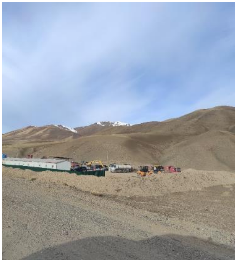
Рисунок 23: Территория второго строительного лагеря (км 106+300) – общий вид
