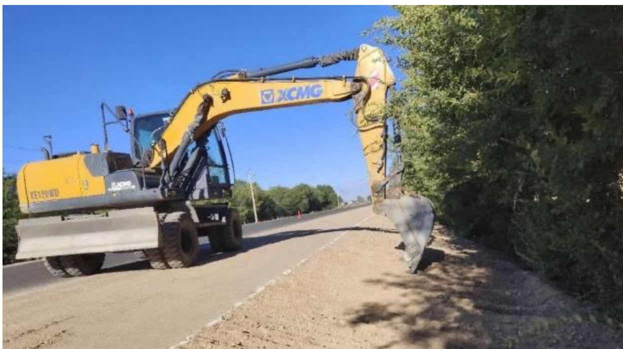
Рисунок 5: Очистка склона обочины, км 137+260 - км 137+100 ПС
