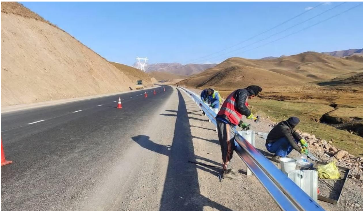
Рисунок 10: Установка волнообразного ограждения, км 113+300 – км 113+512, ЛС
