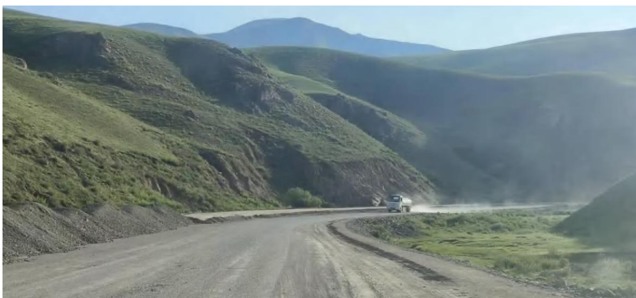
Рисунок 15: Пылеподавление на дороге км 89+500 – км 159+200 (ЛС и ПС)
